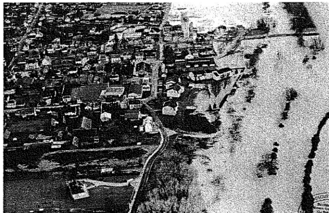
Commune de Vailly-sur-Aisne / crue Aisne de 1993-Source géomètre HOUDRY
