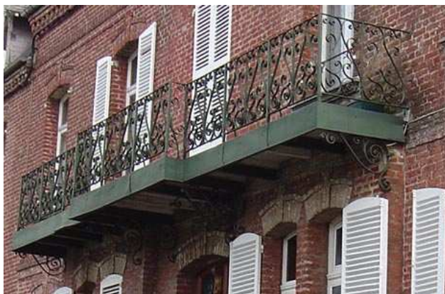
Balcon entièrement en fer
