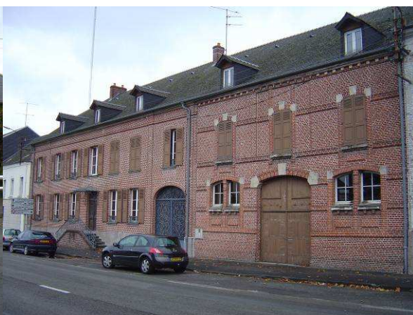
Exemple de ferme au carré dont l'accès aux bâtiments se fait pour certains par l'usoir, pour d'autres par la cours
