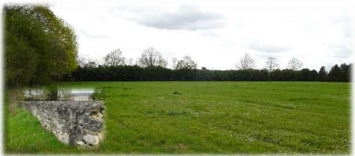
« Prairie Ouest » : en encadré, muret séparant Prairies Est et Ouest – avril 2023
