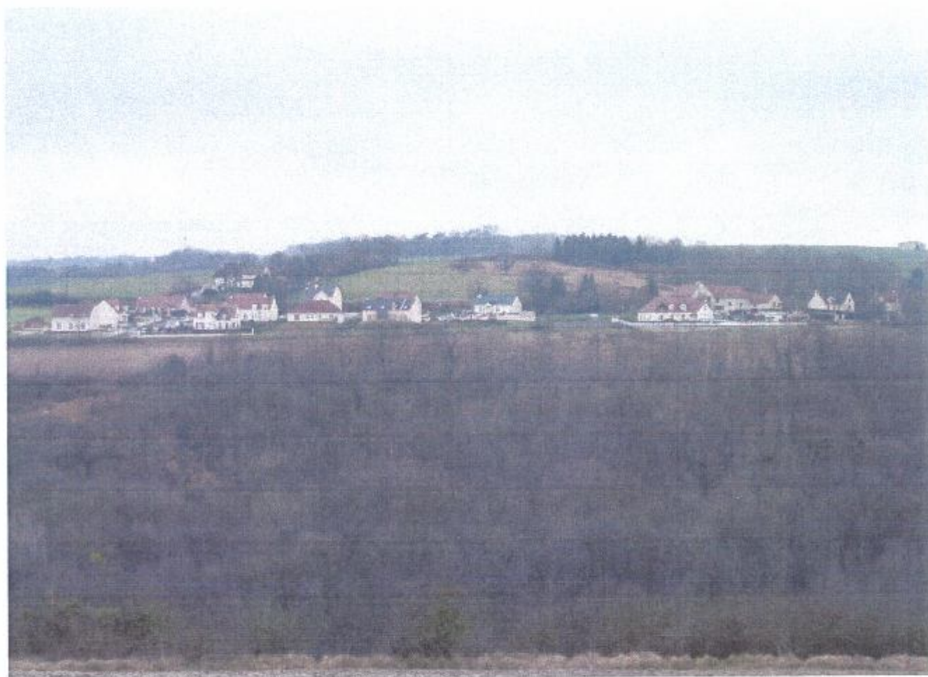
ZONE 1 AU SOUS LA BRIQUETERIE (NOUVEAU)
