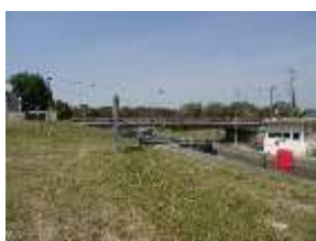
Écluse du Canal latéral à l'Aisne
