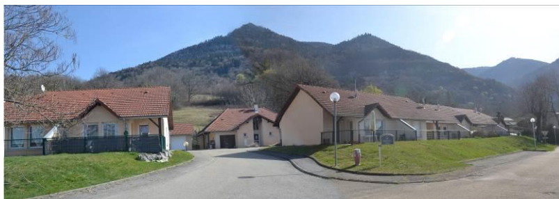
la résidence Assin : 10 logements intermédiaires sociaux
