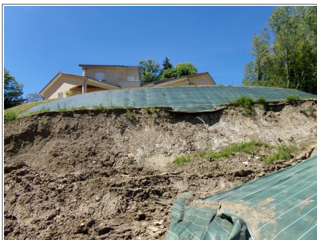
Figure III.36: zone d'arrachement du glissement de terrain de mai 2021 sur la parcelle 403.
