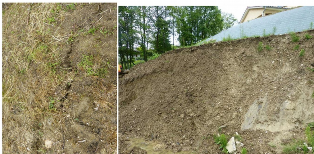
FIGURE 16 : CREVASSE EN ARRIÈRE DU FRONT LATÉRAL NORD ET ACCENTUATION DE L'ÉCARPEMENT DE TÊTE
