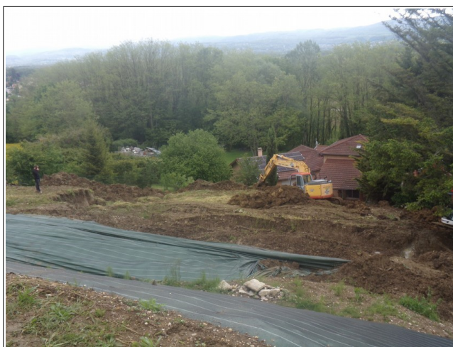
Figure III.37: vue générale vers l'aval du glissement de terrain de la parcelle 403 et de la maison menacée à l'aval.
