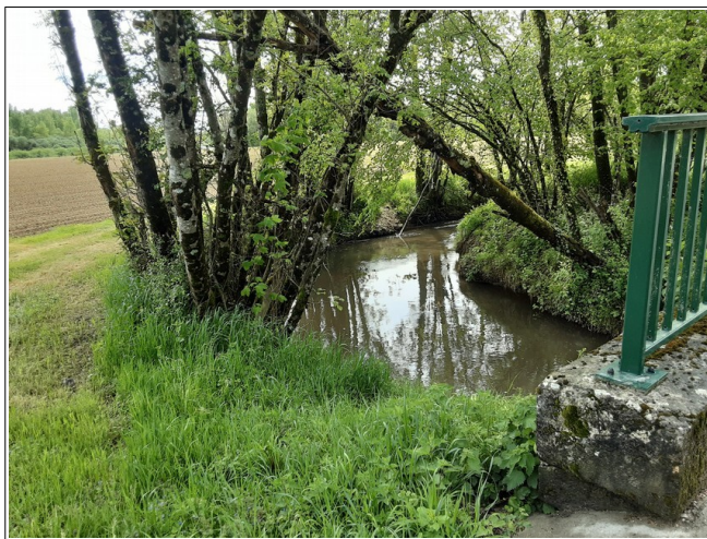
Figure III.31: le Bief de la Fougère au franchissement de la RD984 et son champ d'inondation à l'aval de la route.
