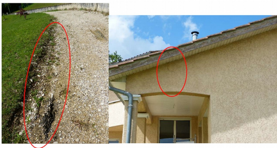
FIGURE 19 : SOURCE EN AMONT IMMÉDIAT DU GARAGE ET FISSURATION
