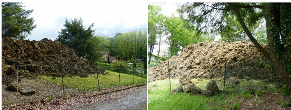
FIGURE 11 : TAS PRINCIPAL STOCKÉ AU SUD DU GLISSEMENT
