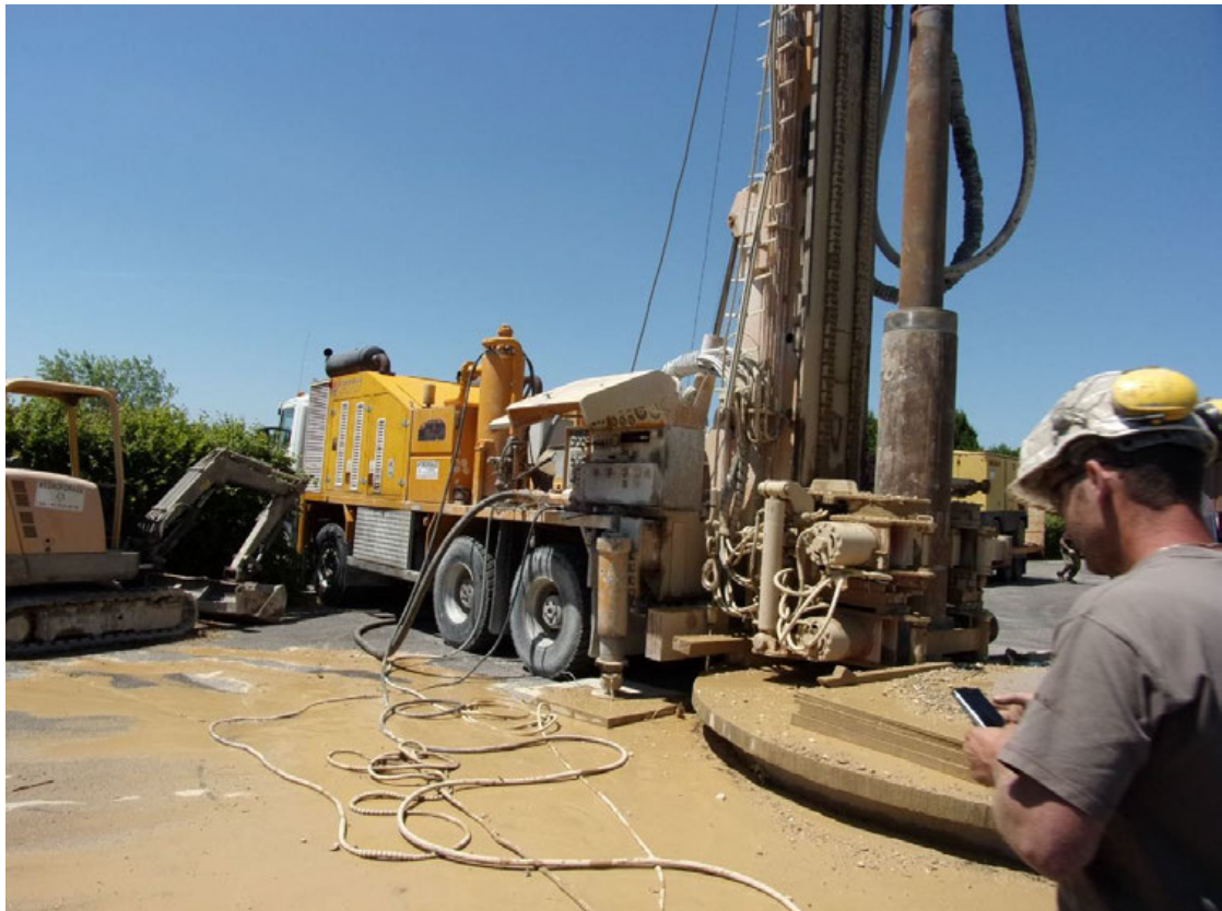
Préparation de la foreuse (forage à marteau fond de trou), Puits 2 Monthieux
