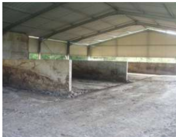
Aire couverte de stockage des boues
