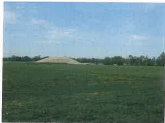
La carrière d'argile (tas de stockage)
