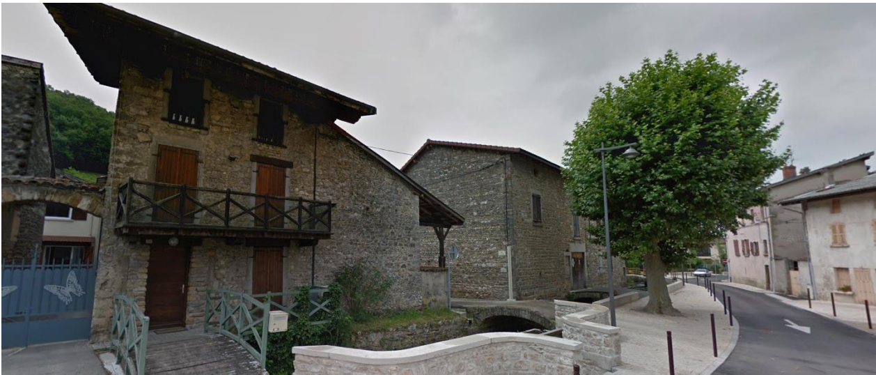
Figure 11. Quai du Buizin dans le centre village présentant une morphologie et des caractéristiques architecturales typiques, structurées par le cours du Buizin.
