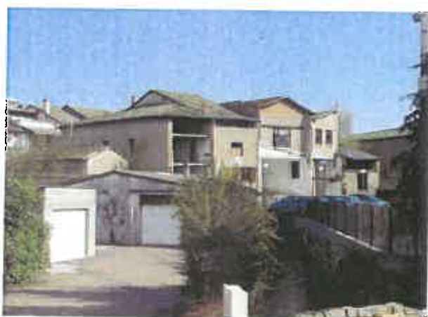
Bâtiment en bordure des Echudes offrant une des meilleures possibilités de réhabilitation sur la commune
