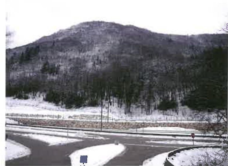
Route départementale D 1504 et voie ferrée (cluse des Hôpitaux)
