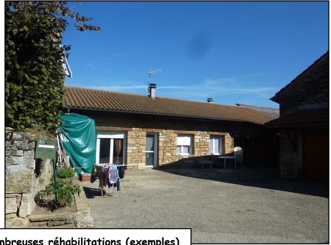
Nombreuses réhabilitations (exemples)
