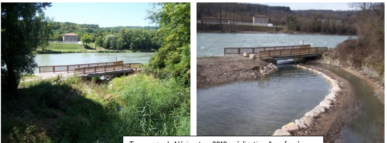
Travaux sur le Nérivent en 2010 : réalisation d'une frayère
