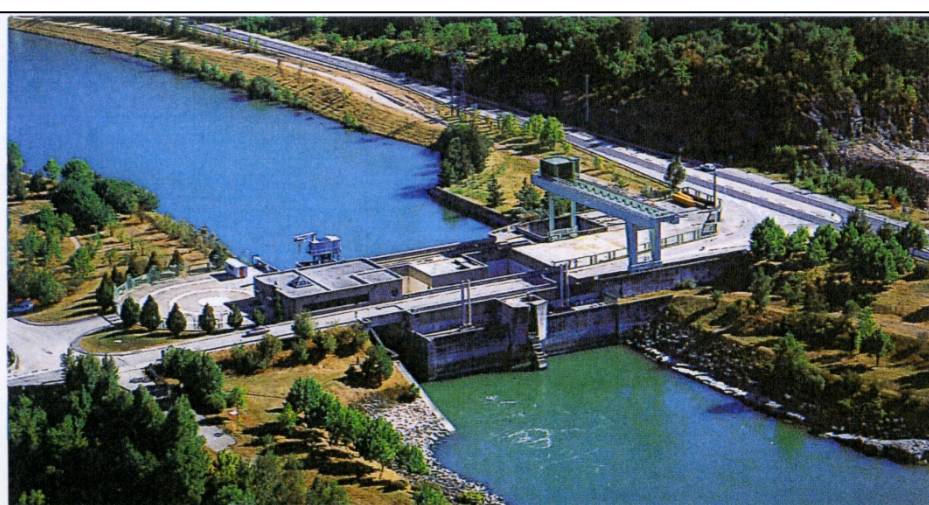
La centrale de Porcieu-Amblagnieu
