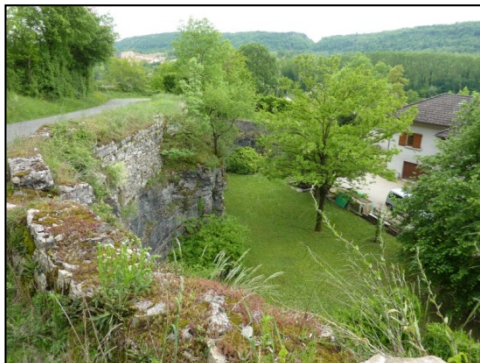
Détail sur le dénivelé en pied de coteau à Brénaz à l'arrière des constructions
