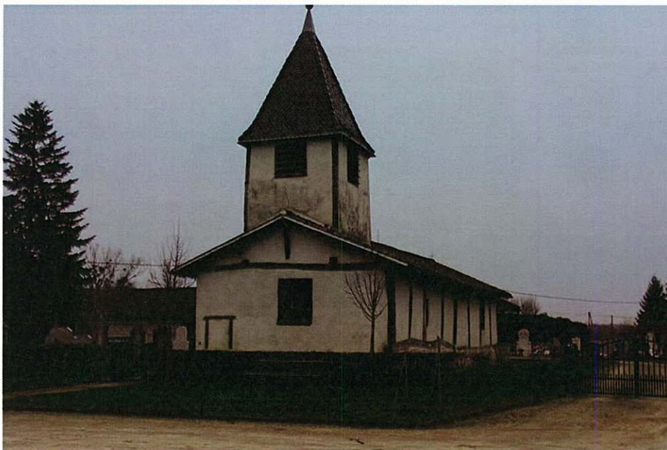
L'église communale avec ses aménagements extérieurs de qualité.
