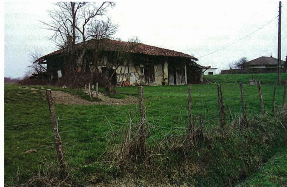
D'autres bâtiments utilisés traditionnellement pour l'agriculture sont à l'abandon et pourraient faire l'objet d'une réhabilitation (ici, à Grand Broguet)
