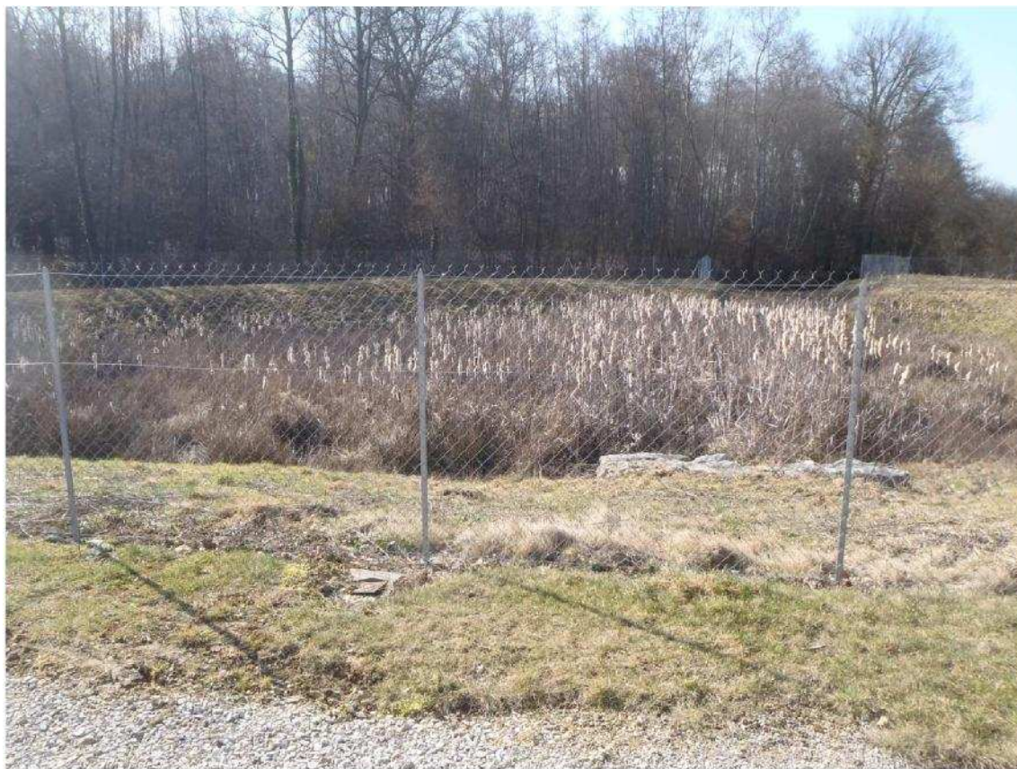
Figure n° 25 : Bassin de rétention au sud du lotissement de Clanchon
