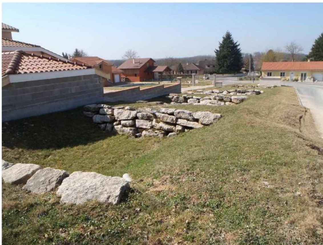
Figure n° 26 : Bassin de rétention du lotissement Route de Corgenon
