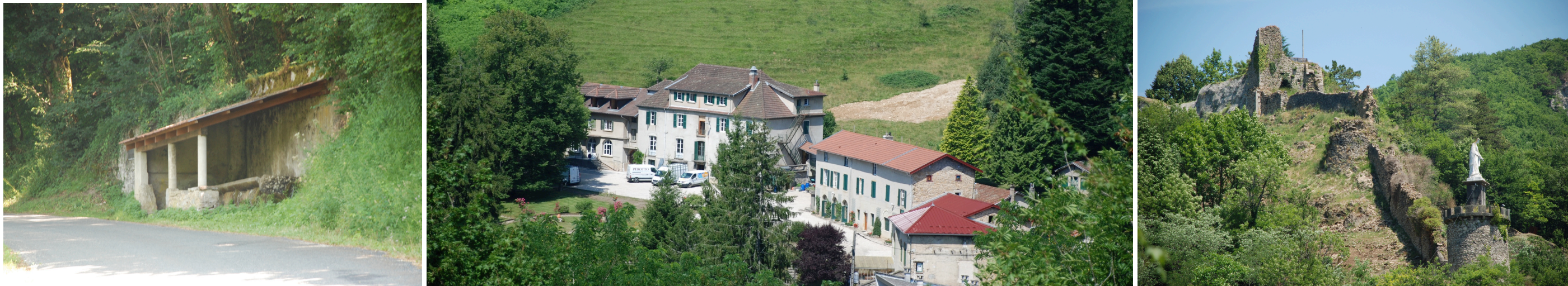
Ci-dessous – Lavoir constituant un élément de petit patrimoine, Abbaye Notre Dame des Missions et vestiges du château de Cornillon – Photographies Atelier du triangle et Mosaïque Environnement
