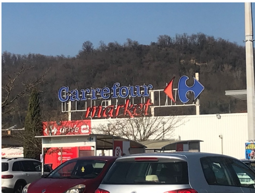
Miribel (structure sur toiture apparente)
