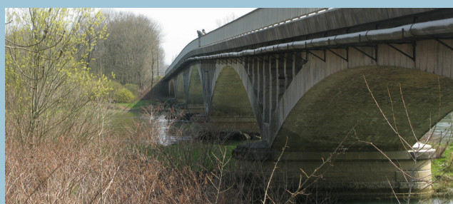
Points de vue sur la rivière d'Aine depuis les franchissements
