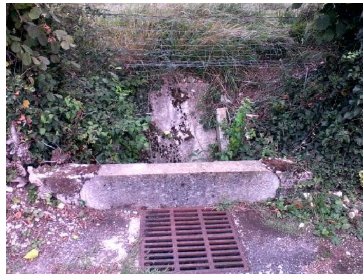
Ouvrage d'entonnement et grille de récupération des EP
