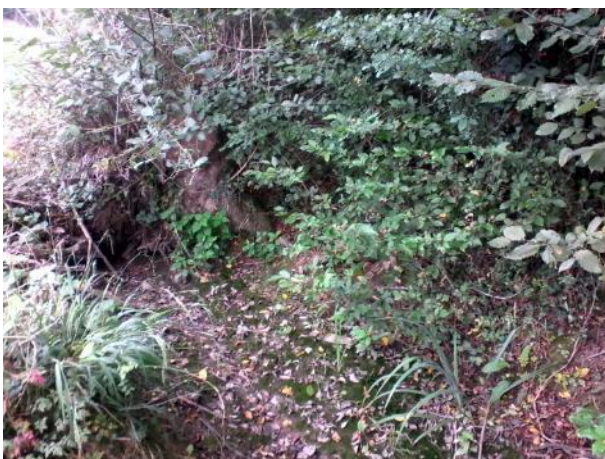
Présence d'un arbre sur l'axe du bief
