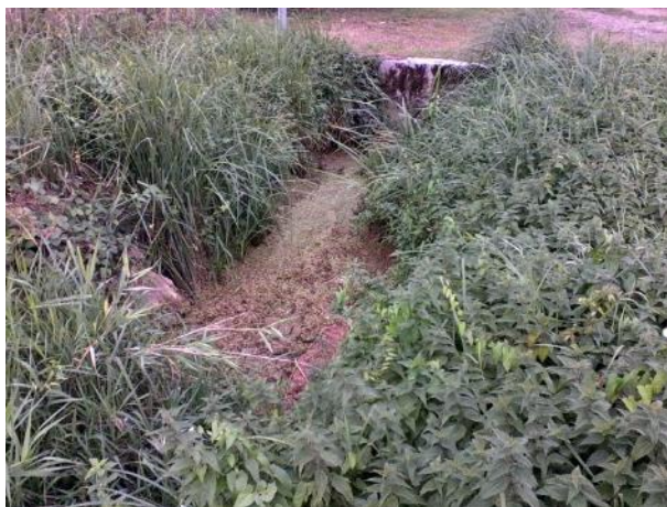
Encombrement du bief (vers la lagune)
