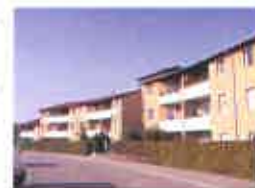
Logements collectifs - ZAC des Tamaris
