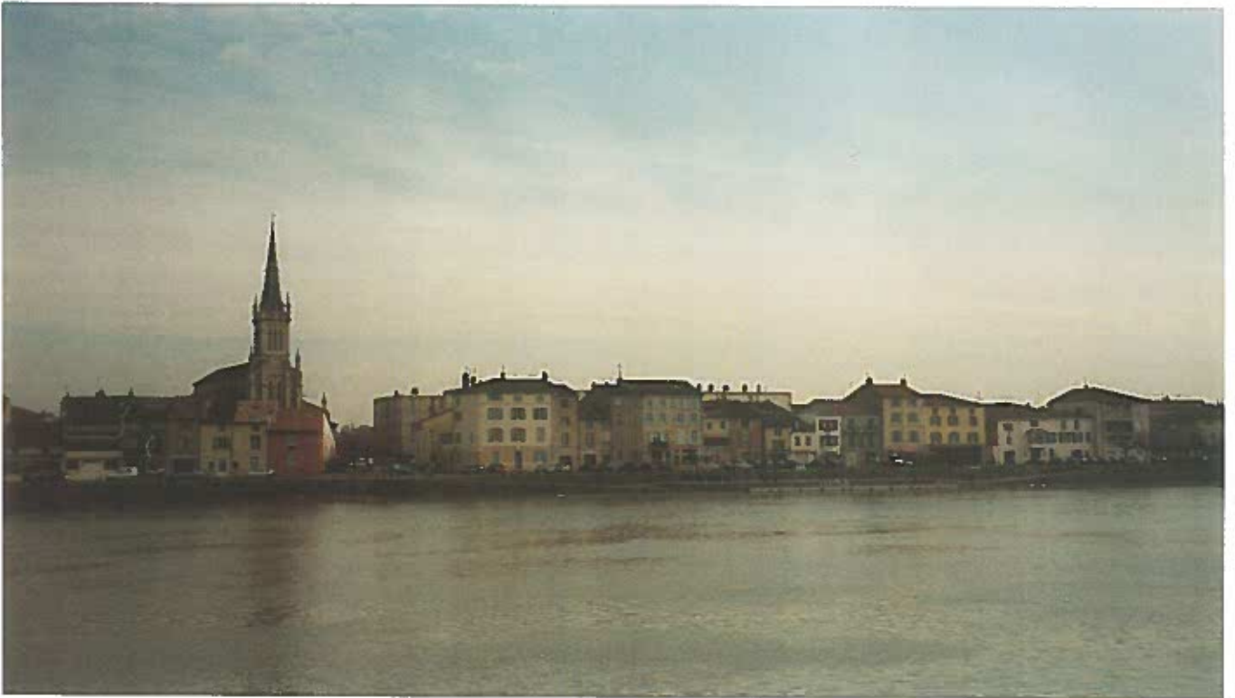
Le front bâti de SAINT LAURENT SUR SAONE, vu depuis MACON avec en point d'origine l'église.
