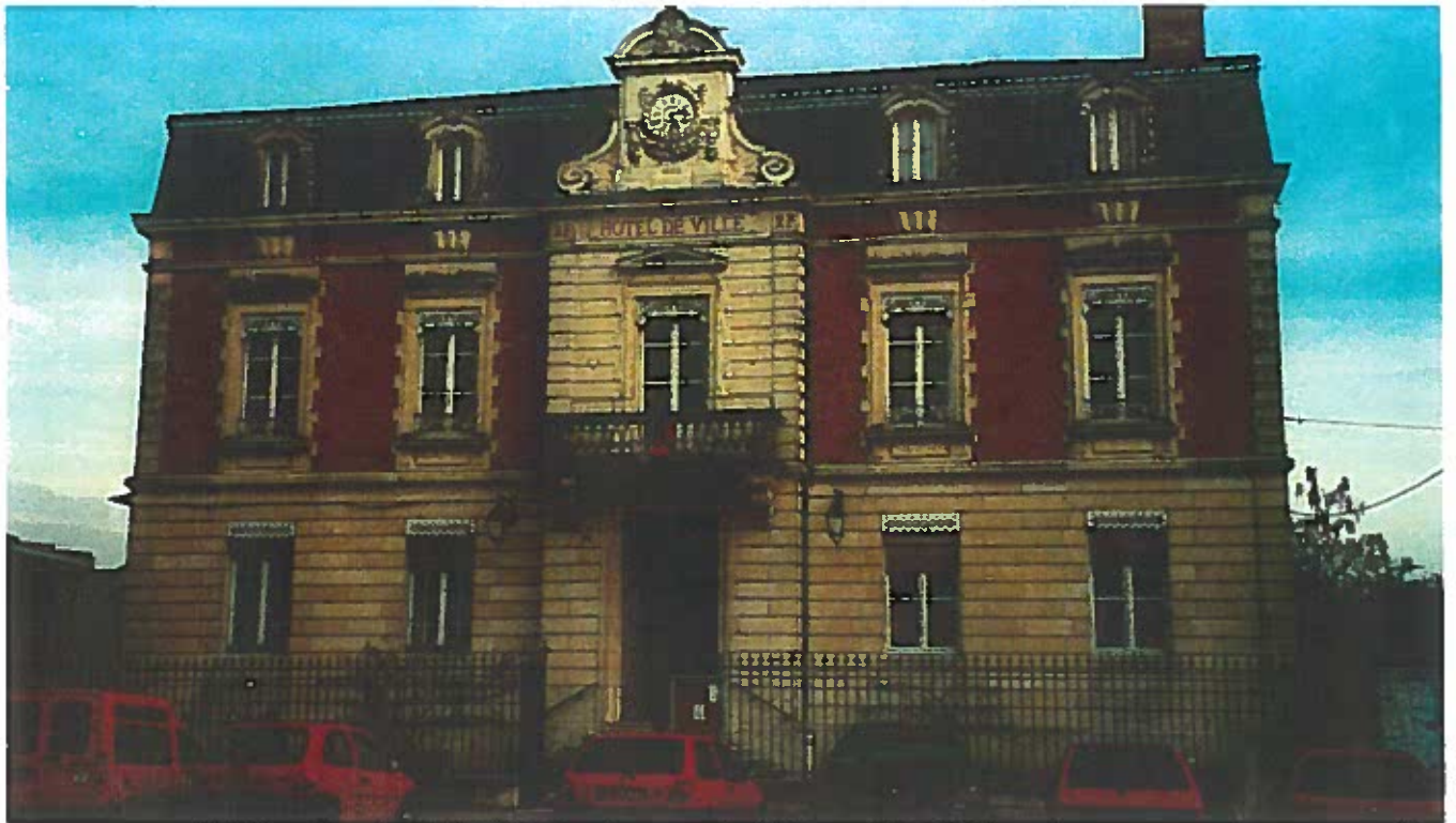
Le bâtiment de la mairie de SAINT LAURENT SUR SAONE sur la place Jules Goyon.
