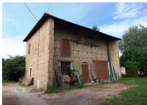
Ancienne ferme isolée Source : BLC, 06-2011
