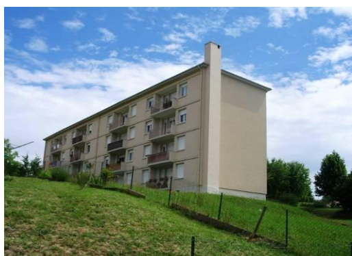
Immeuble collectif en copropriété Source : BLC, 06-2011
