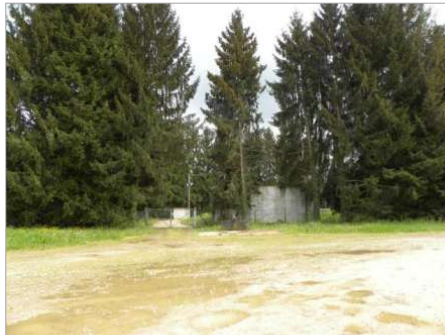
Station d'épuration à proximité de l'étang du Châtelet
