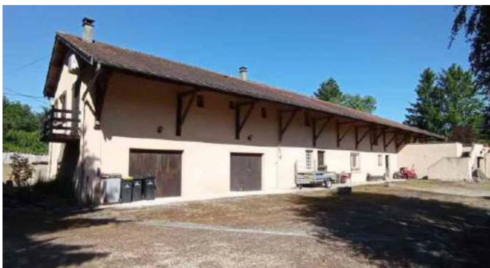
Bâtiment n°17 identifié
