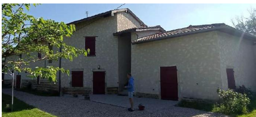
Et dans partie nord du bâtiment 13 :
