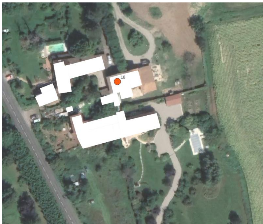
Bâtiment n°18 identifié
