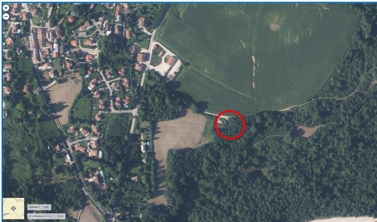
Figure 3 Vue aérienne de la STEP de BELLEGARDE
