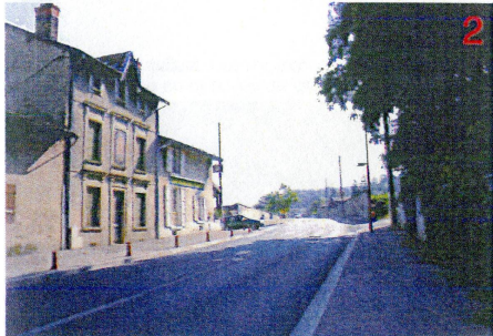
Vue de la RD 1084 en direction du sud-ouest au niveau du carrefour de la limite est du site (giratoire prévu). Bâti en alignement sur rue, mur de séparation de part et d'autre de la RD.
