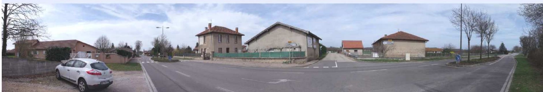
PHOTOGRAPHIE 26 : Entrée Est de la commune sur la Route de Bourg. L'aménagement de voirie et la présence d'une ancienne ferme en pisé signalent l'entrée de la commune.
