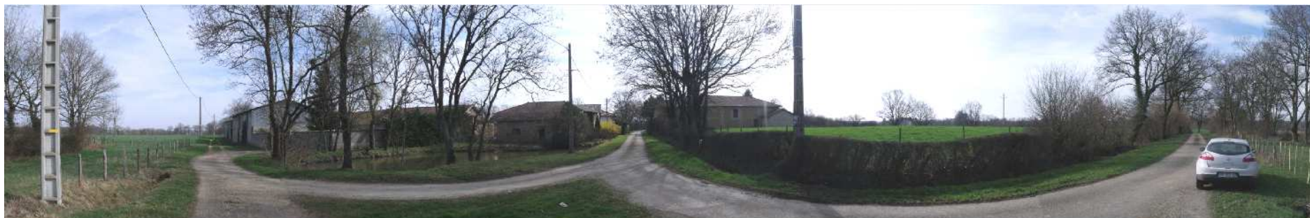
PHOTOGRAPHIE 10 : Vue de la ferme du Bouchet au Sud-ouest du noyau villageois. Composée de nombreux corps bâtis, elle reflète l'habitat agricole du territoire communal. La marre près des habitations témoigne de l'extraction de la terre destinée au pisé.
