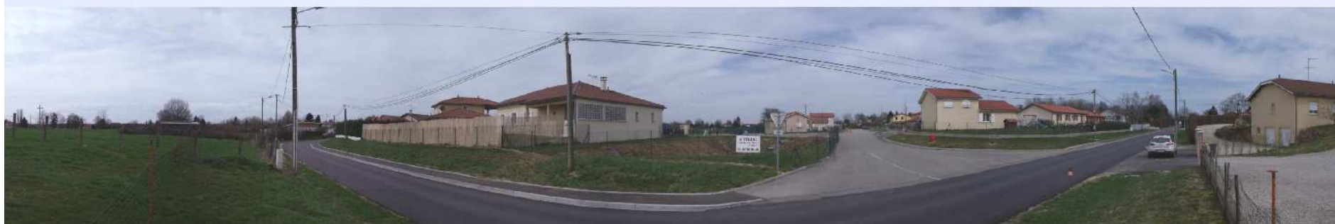
PHOTOGRAPHIE 35 : Vue des lotissements pavillonnaires sur la route de Condeissiat : l'anonymat de la typologie des lotissements se combine à leur isolement et génère un flou quand au statut de ces quartiers satellites.
