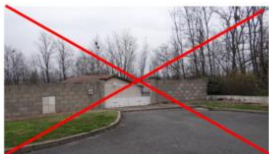
Mur en moellons non enduits
