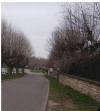
Mur ancien rabaïssé avec grille
