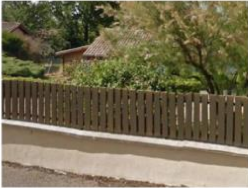
Clôture en bois « naturel »
