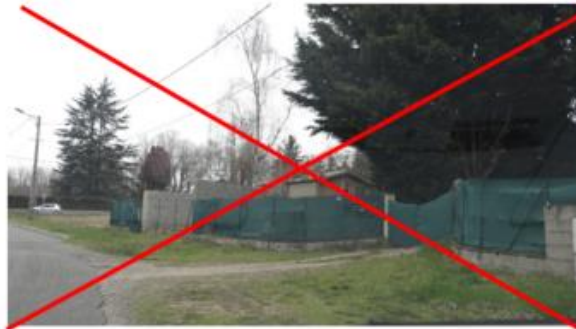
Bâches plastiques très abimées
