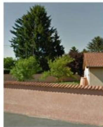
Mur moderne enduit avec faitage de tuiles
