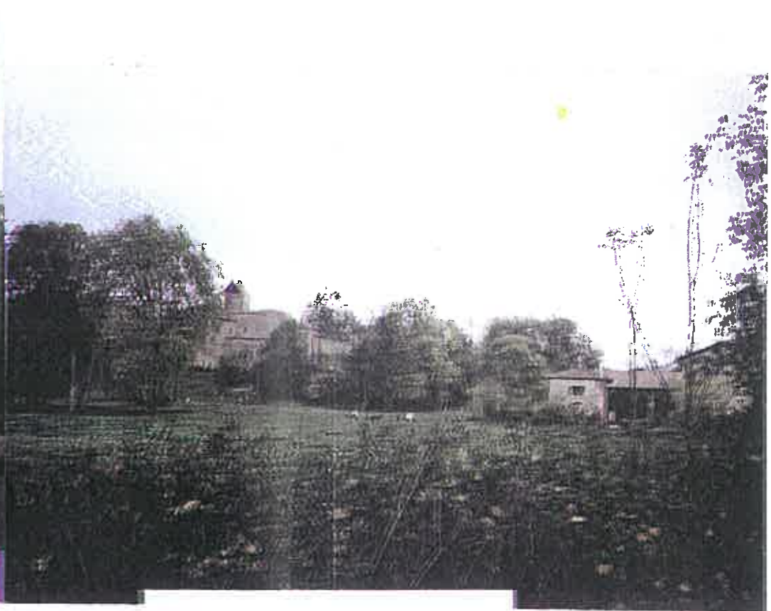
3 - Vue sur le château au croisement de la RD 61 et de la voie communale formant une ceinture autour de ce monument.
