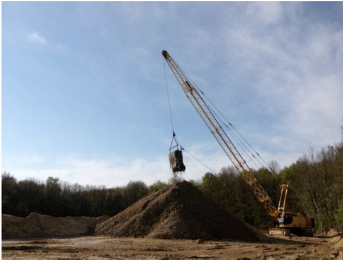
Extraction avec une dragline
