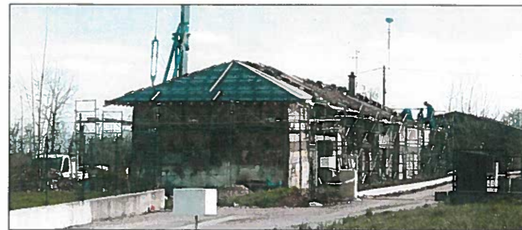
Exemple de réhabilitation
