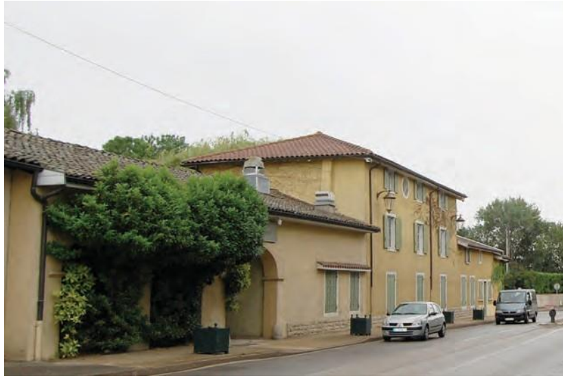
Bâtiment de l'ancien restaurant Alain Chapel
