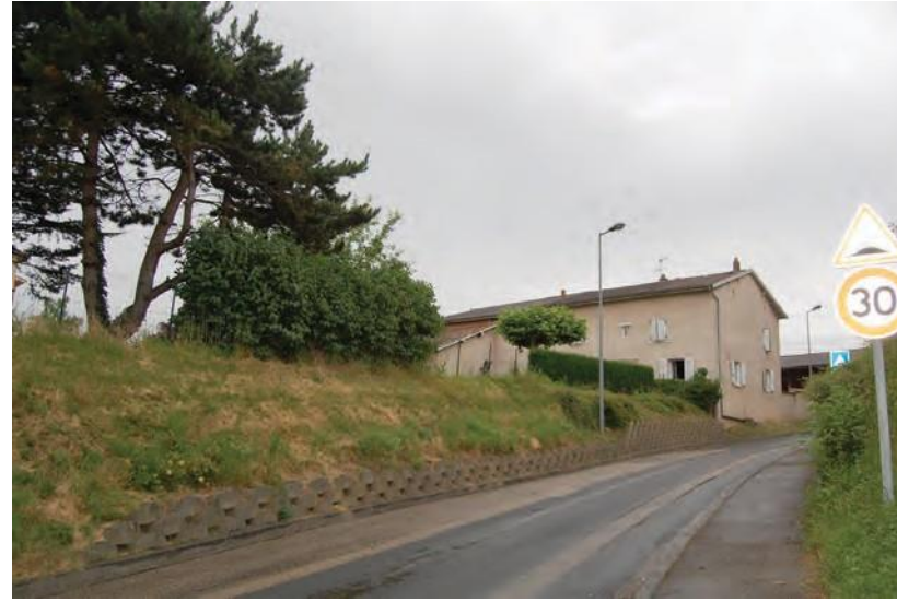
Chemin du Beau logis : dénivelé
