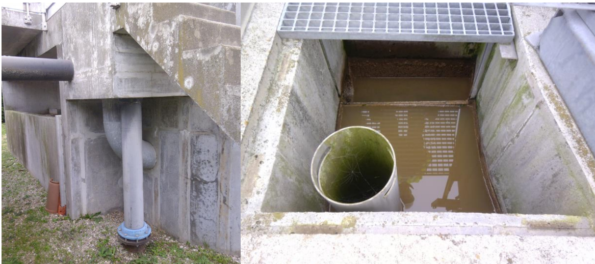
Figure 15 : Zone de répartition amont bassin d'aération
