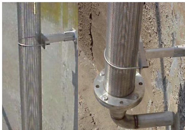
Figure 33 : Exemple de drains
