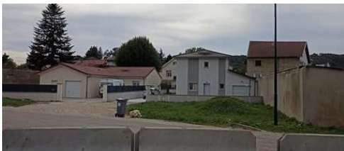
Bâti pavillonnaire au Sud des garages
