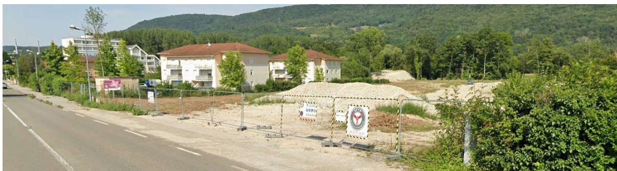
Chantier de la nouvelle gendarmerie (pendant l'étude du PLU) et en arrière-plan les deux immeubles de La Bergerie et la gendarmerie destinée à disparaître
