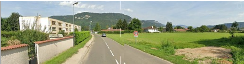
Vue depuis la Route de Posafol (RD40)
