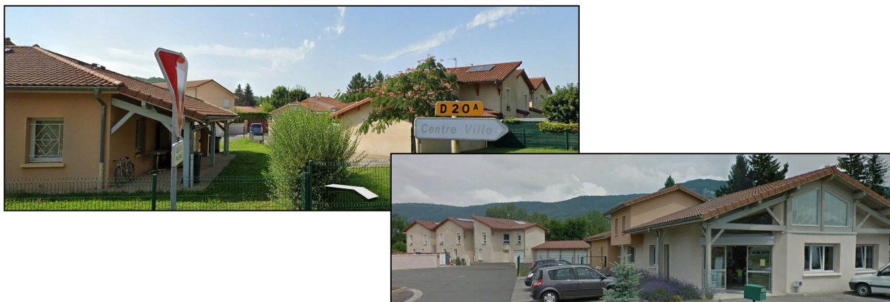
Non loin, route du Port, une opération d'habitat individuel dense (lotissement des Coquelicots)
