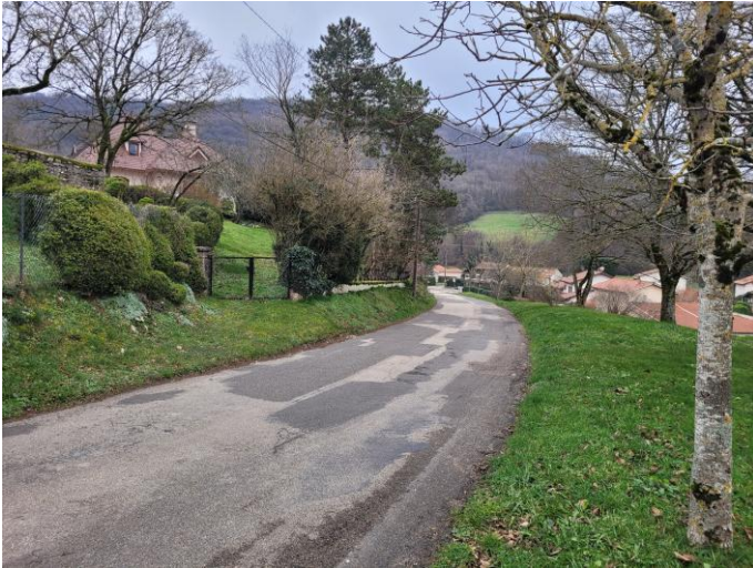
Vue sur la montée de Boisserolles depuis la montée, au droit du site. Le mur d'enceinte est visible à gauche.
