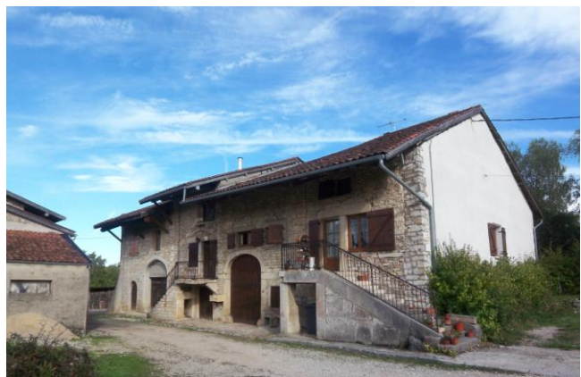
Bâti traditionnel – photos BLC 2010
