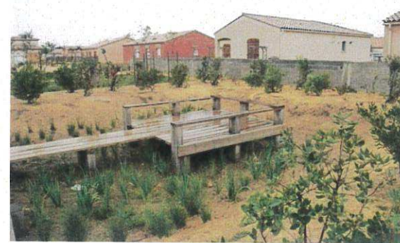
Bassin de rétention paysager en entrée de lotissement et noues aménagées au cœur d'un espace public dans un lotissement.
