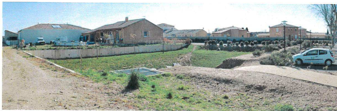
Bassin de rétention paysager en entrée de lotissement et noues aménagées au cœur d'un espace public dans un lotissement.
