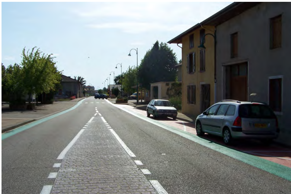
La Route Départementale 28 dans la traversée d'agglomération.
