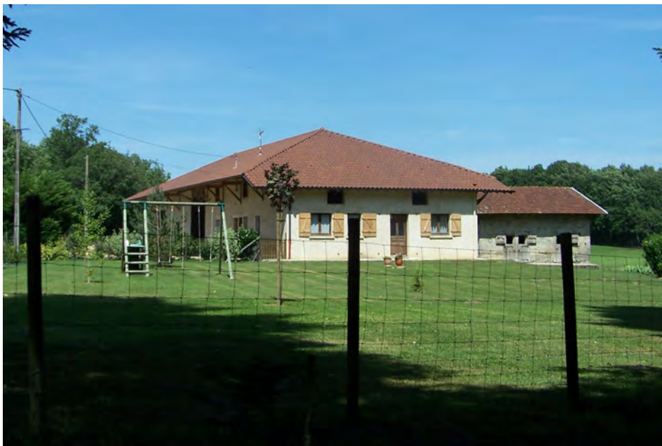
Les constructions isolées n'ont plus forcément de lien avec la fonction agricole (ici, à l'étang Pichon, vue du sol)
