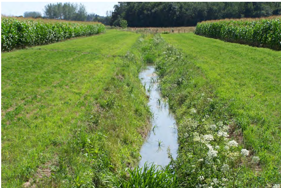
Le Bief des Tronches passant au milieu des champs de maïs restés en retrait de la tranchée en eau
