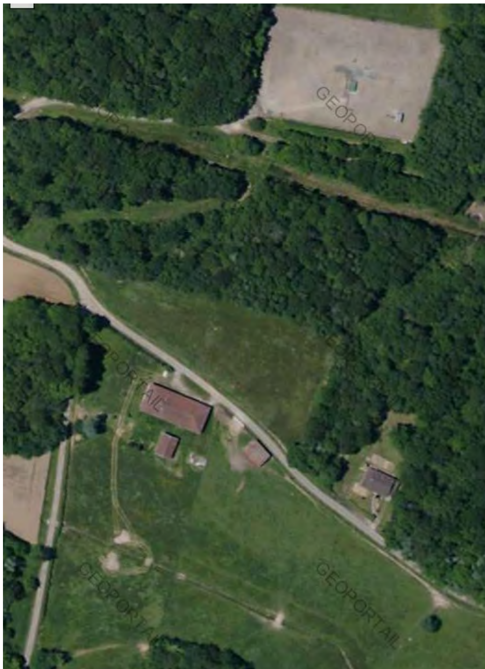
Ancienne ferme renovée de l'Etang Pichon, encerclée par les espaces boisés. Les puits de stockage de gaz et stations relais sont aussi disséminés sur le territoire (ici, un exemple en haut de la photo).
