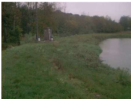
Photo 7 : Poste de relevage
