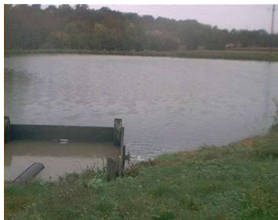
Photo 8 : Arrivée des eaux usées dans le premier bassin
