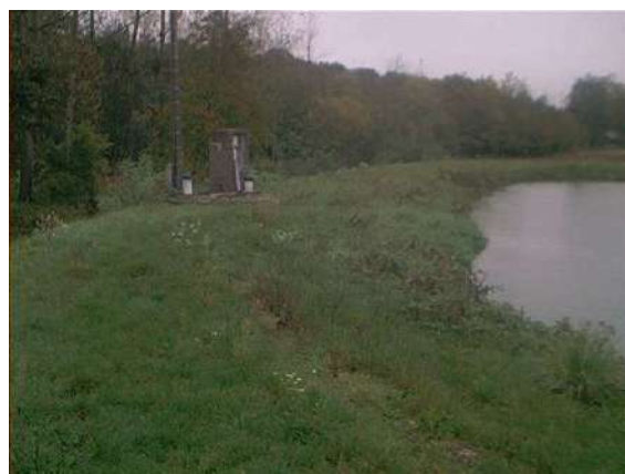
Photo 7 : Poste de relevage
