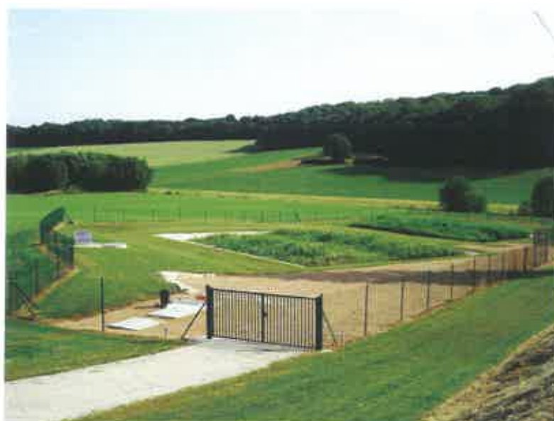
Lagunage de Domsure Source : BLC, 2011
