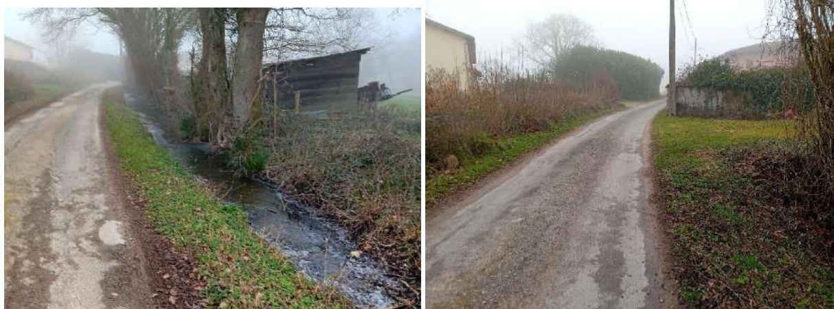
Figure 26 : Photographie du site du problème 5
