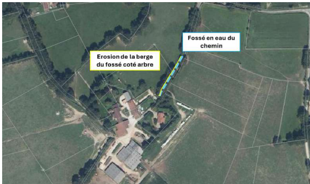
Figure 25 : Description problème hydraulique 5
