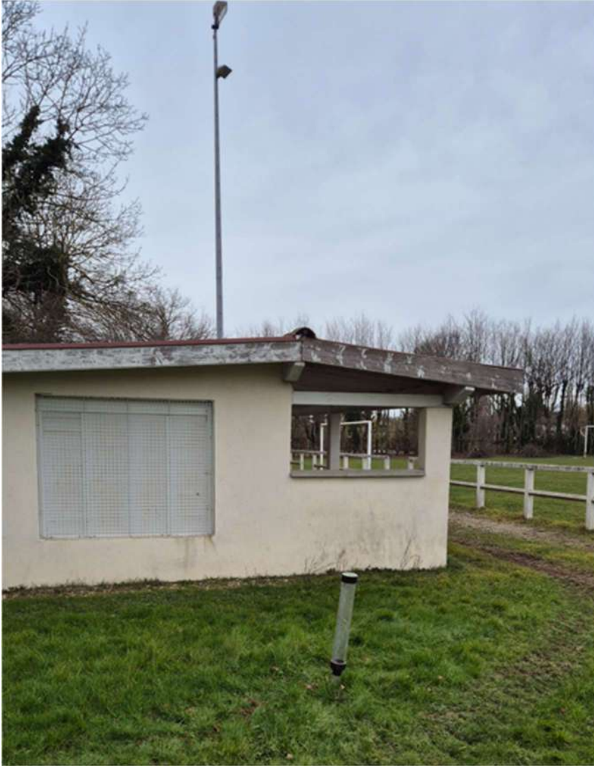
Photographie du sondage et test de perméabilité
