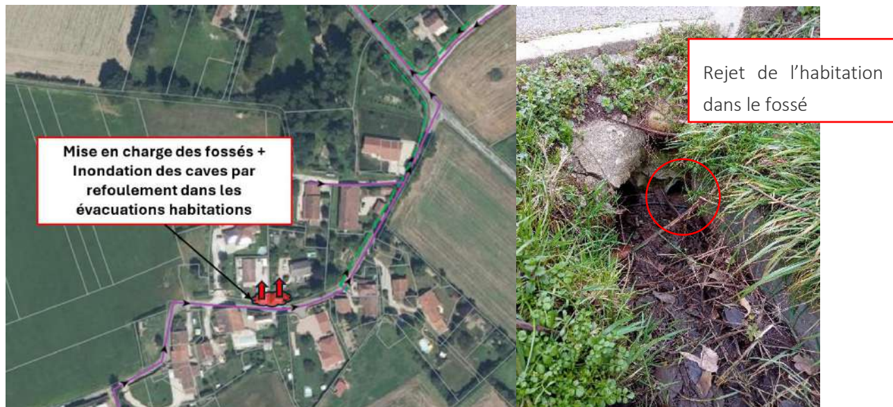
Figure 24 : Description problème hydraulique 4
