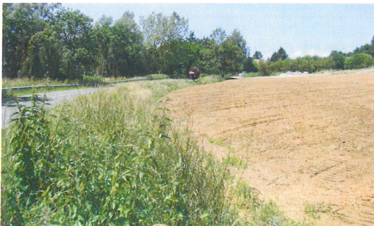
Planche photo 1 : le site a fait l'objet d'un remblai partiel après déconstruction et évacuation de matériaux
