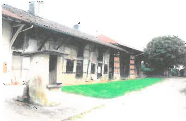
7. Dans le bourg, bâtiment ancien en mauvais état
