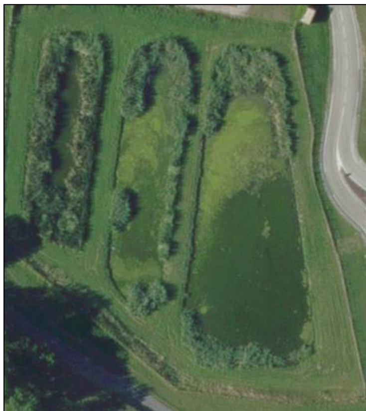
Figure 7 : Vue aérienne du lagunage à Cressin-Rochefort (source : Geoportail)
