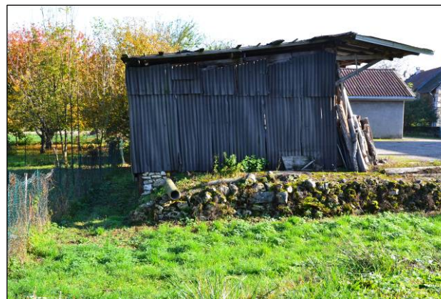
Dénivelé autour de la zone bétonnée située à l'ouest de la zone 1AU
