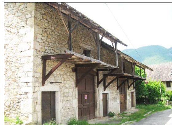
Débord à consoles
