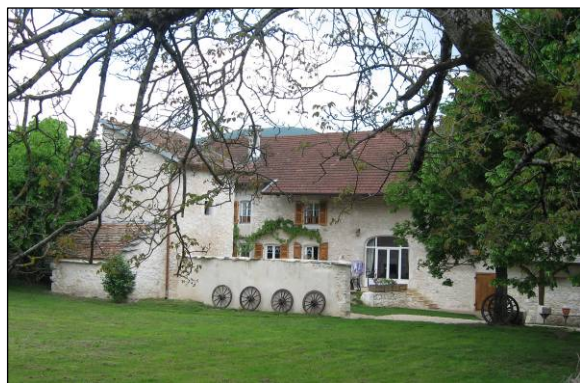
Murs en pierre et volets en bois
