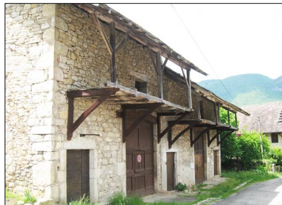
Débord à consoles
