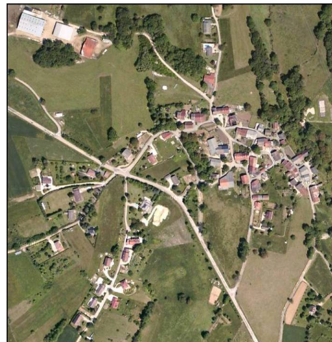
Vue aérienne sur le hameau de Boissieu
