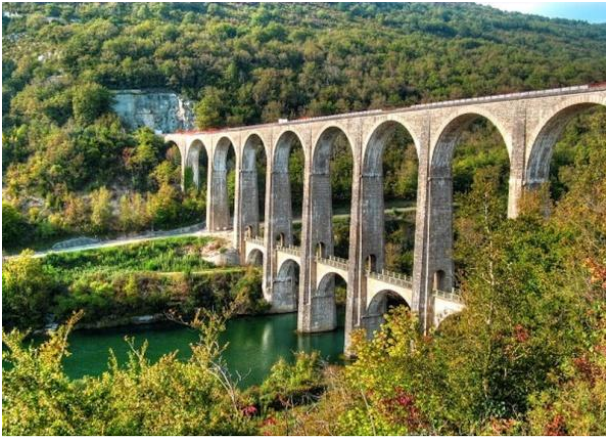
Viaduc de Cize-Bolozon -
