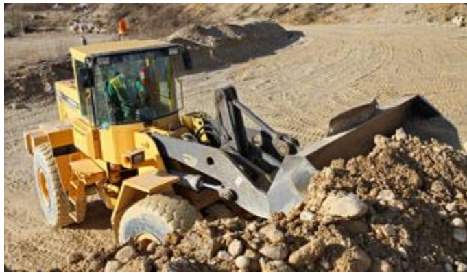
Chargeuse de l'entreprise Fontenat A.G. sur le site d'Hautecourt Site web de l'entreprise
