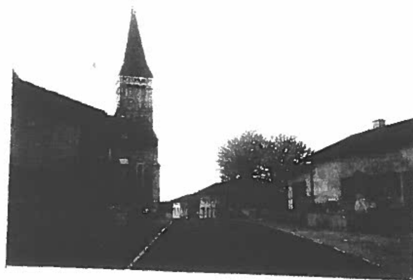
Le bourg de CHATENAY est constitué d'un noyau ancien composé de maisons assez basses implantées de part et d'autre de l'église.
